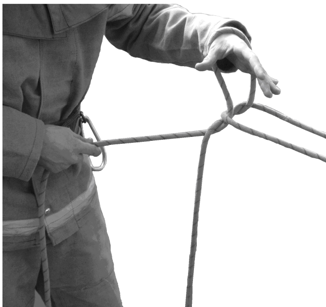
Рисунок 19 (7) – Закріплення рятувальної мотузки за конструкцію третім способом
