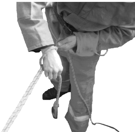
Рисунок 17 (4)– Закріплення рятувальної мотузки за конструкцію першим способом
