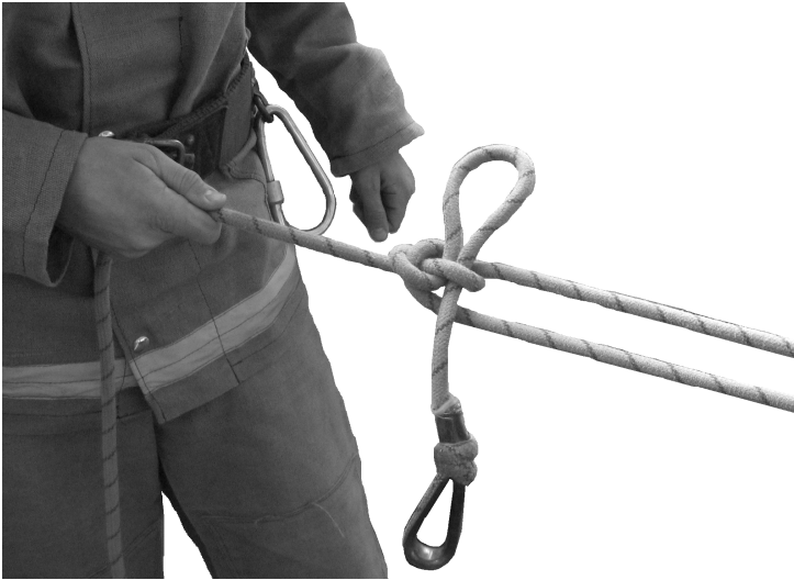
Рисунок 20 (6) – Закріплення рятувальної мотузки за конструкцію четвертим способом
