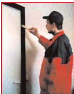
Фото 4. Нанесення антипірену на деревину
