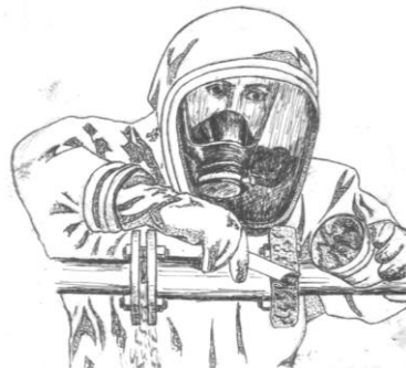
Підкарбування з'єднань
