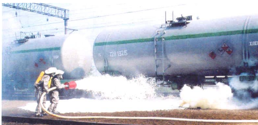
Рис. 2.6-Ізоляція розливу НХР піною середньої кратності.
