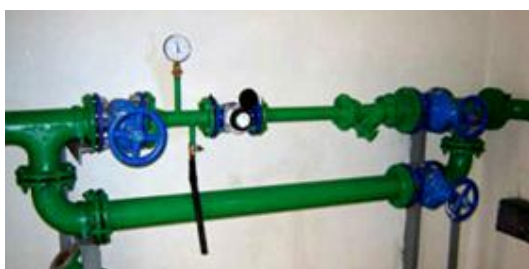
Рис. 2.45 – Водомірний вузол
