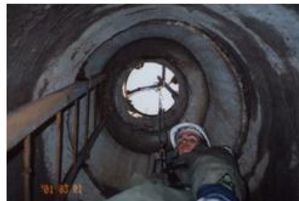
Підйом постраждалих з колодців за допомогою триноги
