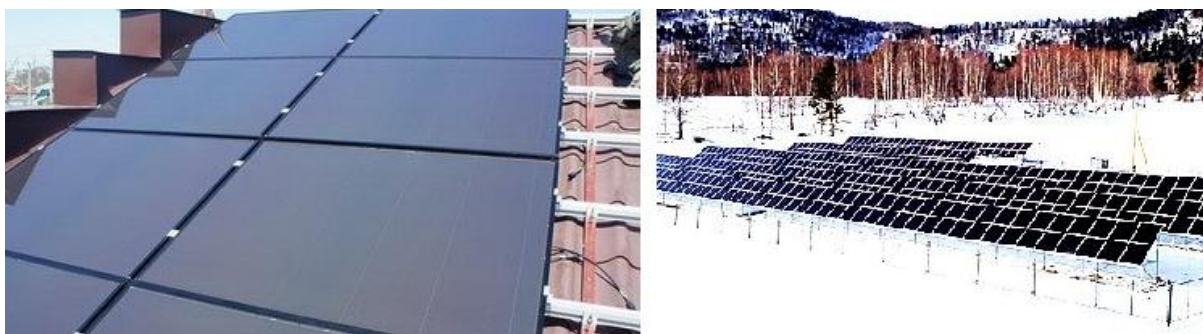
Рисунок 6.4 – ФЕП з аморфного кремнію (a-Si)
