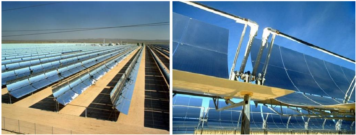
Рисунок 6.9 – Параболоциліндричні концентратори
