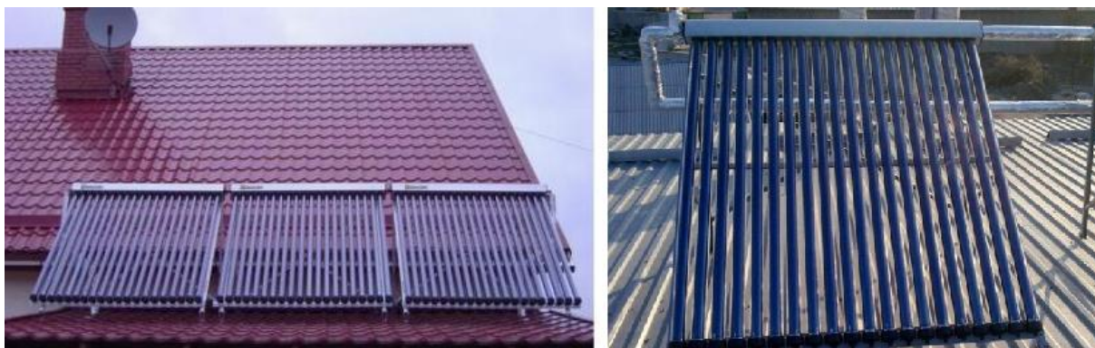
Рисунок 6.7 – Вакуумні сонячні колектори
