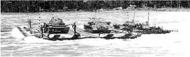
Рис. 2.40. 90-тонний пором, який штовхають два катери БМК-225
