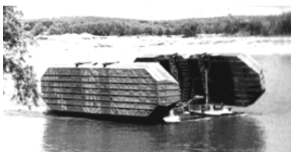
Рис. 2.19. «Розкриття» парому ГСП
